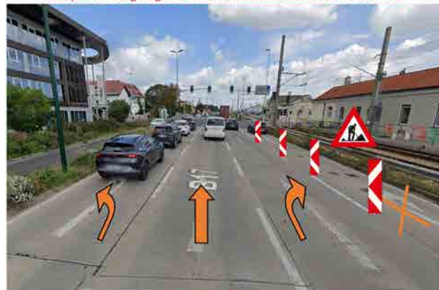
B 17 Wienerstraße/Hauptstraße - Fahrtrichtung Norden
