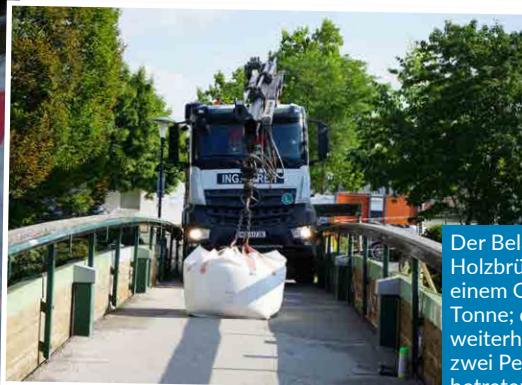
Bgm. Herbert Janschka, 1. Vize-Bgm. DI Norman Pigisch sowie Ziviltechniker für Bauwesen DI Markus Kuhlang gaben den Gehweg unter der Brücke frei.
